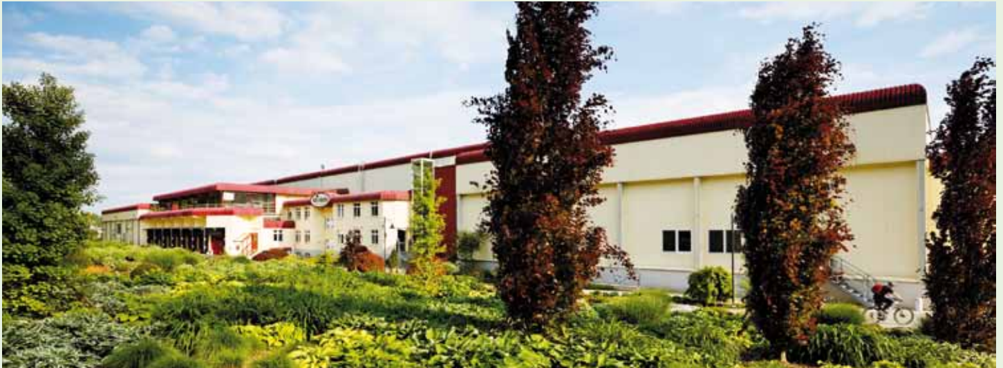
Eine Photovoltaikanlage am Dach der Firmenzentrale produziert 200.000 KWh Strom pro Jahr.
