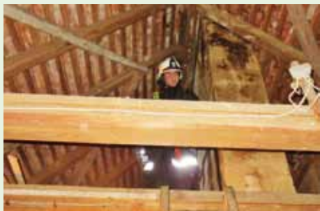
Kontrolle des Kamins
